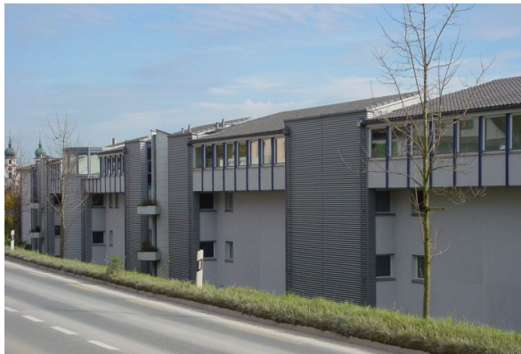
Abb. 21.1 Überbauung Rothenburgstrasse, Eschenbach LU (schallabsorbierende Fassade)
