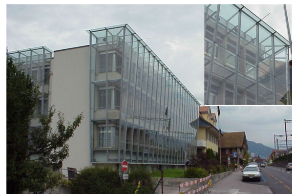
Abb. 21.8 Wohnhaus Spiez BE (vorgehängte Glasfassade) (Quelle: B. Staiger, Horw)
