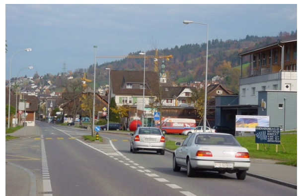
Abb. 20.8 Neue Ortseinfahrtsgestaltung (Mittelsinsel für Fussgänger), Root LU
