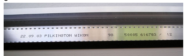
Abb. 17.18 Herstellerangaben im Randverbund der Isolierverglasung
