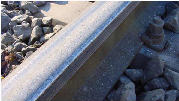
Abb. 8.2 Industriegleis mit schwacher Riffelbildung
