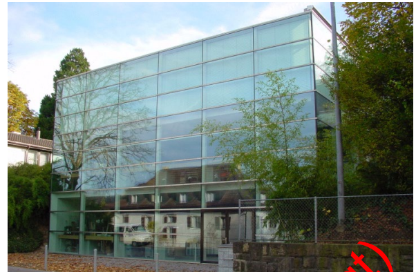
Abb. 21.5 Geschäftshaus Baltensweiler, Ebikon LU (Glasfassade, klimatisiert, Schallschutzgläser)
